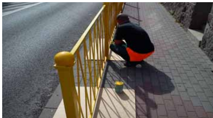
Nadal trwają prace rozpoczęte: ul. 3 Maja - konserwacja bariery ochronnej
