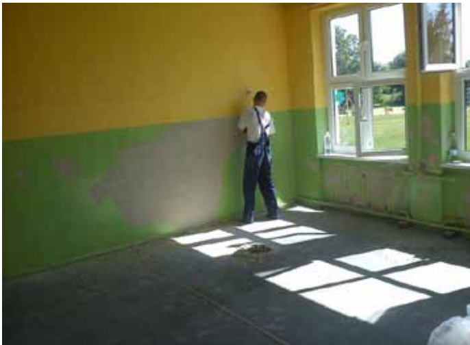
Szkoła Podstawowa w Strzelewie – remont trzech klas lekcyjnych
