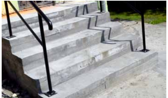
Szkoła Podstawowa w Żabowie – postawienie nowego ogrodzenia wokół szkoły i remont schodów.
