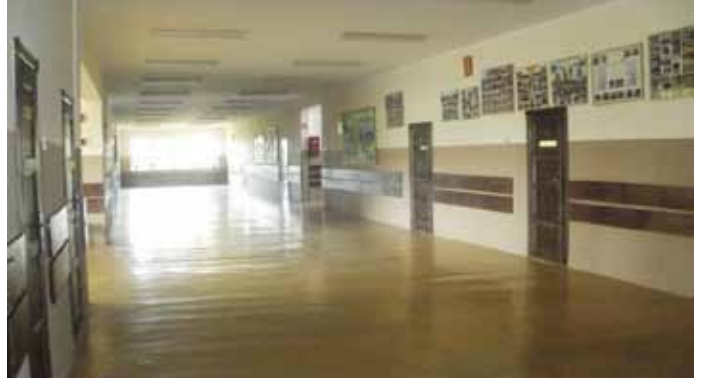
Szkoła Podstawowa nr 3 w Nowogardzie – remont dolnego korytarza i świetlicy
