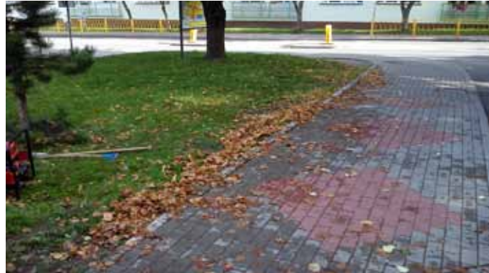
ul. Kościelna - usunięcie barierek
