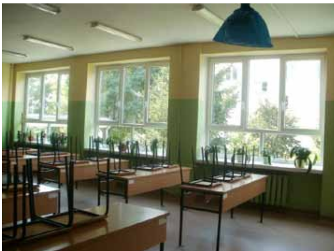
Wymiana stolarki okiennej w Zespole Szkół Ogólnokształcących – łącznie wymienionych zostało 49 sztuk okien o całkowitej powierzchni 228,40 m 2 . Całkowity koszt inwestycji wyniósł 64.845,60 zł. Ponadto w Gimnazjum nr 1 osadzeni wyremontowali klasę z przyległym gabinetem.
