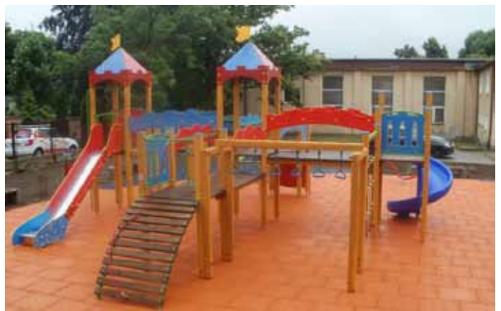
Budowa placu zabaw przy Szkole Podstawowej nr 1 – plac powstał w ramach rządowego programu „Radosna Szkoła”. Całkowity koszt realizacji inwestycji wyniósł: 193.064,50 zł brutto.
