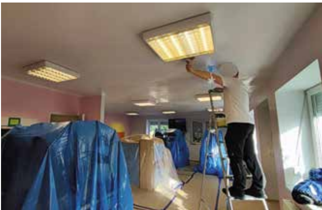
Remont pomieszczenia w budynku świetlicy Promyk
