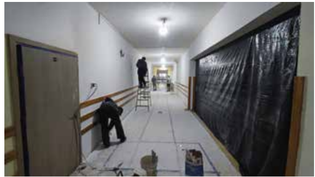
Remont korytarza w Liceum Ogólnokształcącym nr 2
