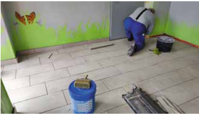
Remont korytarza w Szkole Podstawowej w Strzelewie
