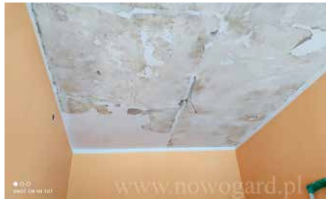
Remont pomieszczeń gminnych
